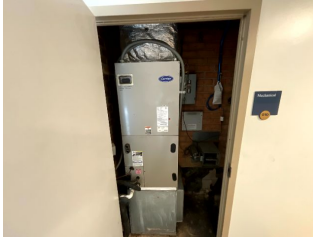
Fan Coil Unit - DX Cooling - 3.5 Ton
